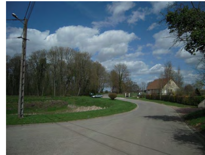
Mare à réhabiliter
