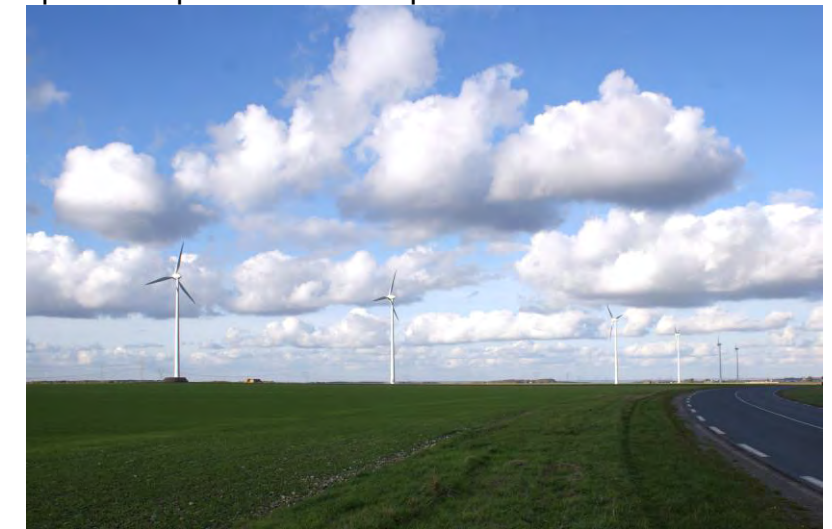
RD1001 et Parc éolien d'Oresmaux
